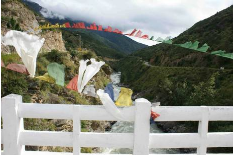
Brücke über den vereinten Thimphu- und Paro-River
